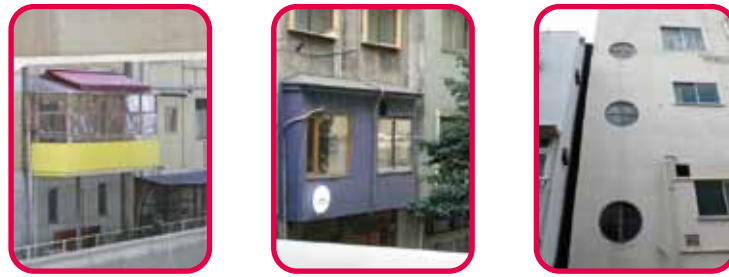
川に向けたテラス 壁面塗装・川に向けたサインと植栽 デザインされた開口部
