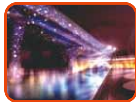
高架下のライトアップ
