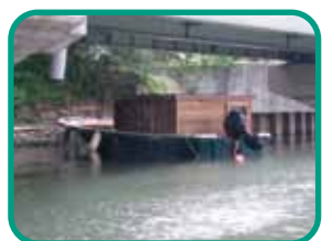
小型船が寄り付ける護岸形状
