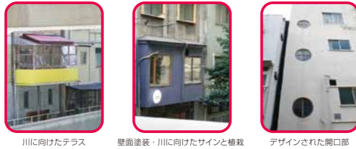
川に向けたテラス 壁面塗装・川に向けたサインと植栽 デザインされた開口部
