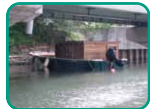
小型船が寄り付ける護岸形状
