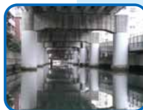
高架に覆われた閉鎖的な河川空間
